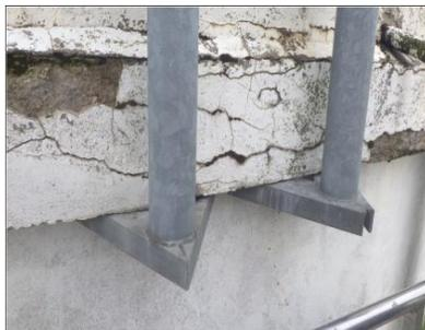
Dégradation de la ceinture liée aux fixations d'antennes
